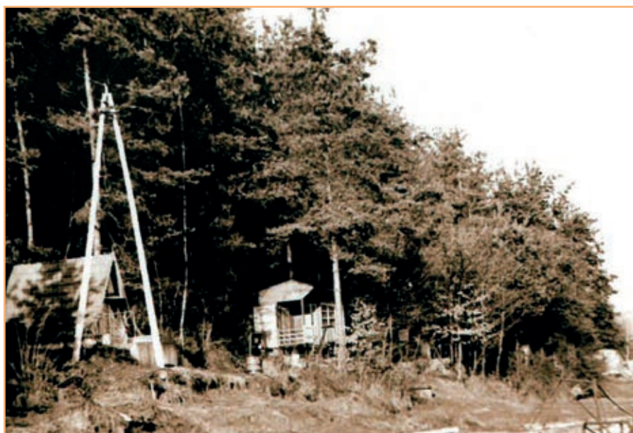
Kompleks wypoczynkowy „Pod Charstkiem”, zlokalizowany w rejonie przyszłej zapory (ok. 1970 r.)
