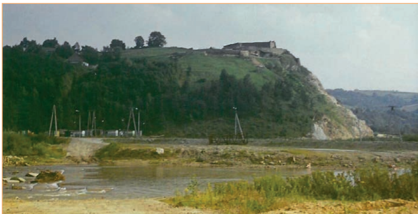
Przygotowania do budowy zapory w Dobczycach.
