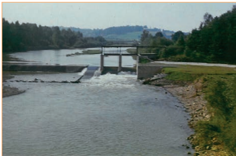
Jaz na rzece Rabe - pierwszy etap wodociągu Raba
