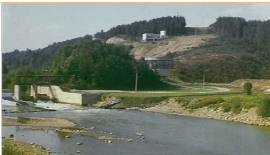
Widok na jaz, tymczasowe ujęcie oraz budynek bań.
